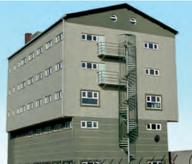
Eleksan - İstanbul tesisleri
